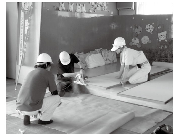
▲山内保育所で修繕作業する建労組合員の皆さん
