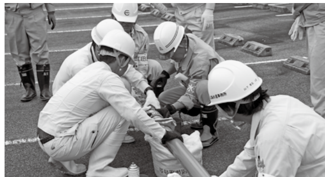
▲県内市町の職員が協力し水道管修復を訓練
