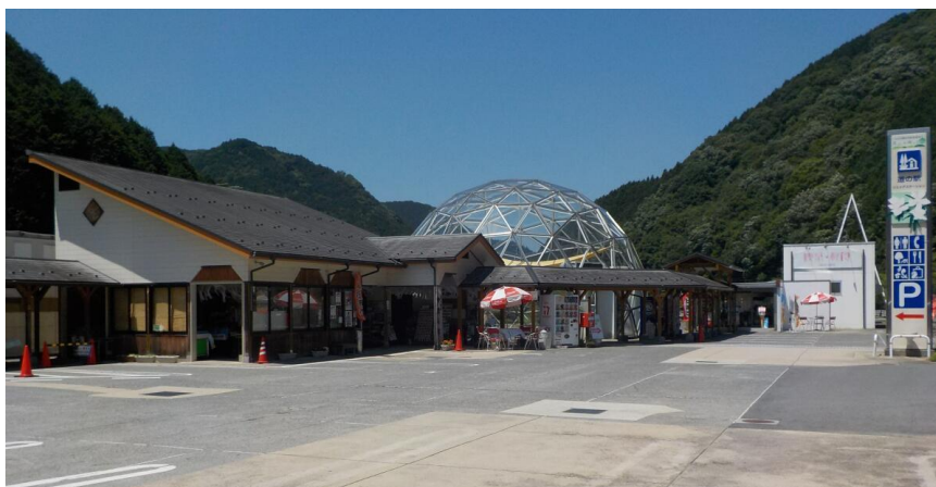
施設を改修した 道の駅リストアステーション (中国自動車道・庄原IC下車20分)
