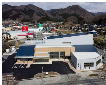
東城自治振興センター整備
