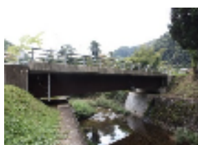
新濁田橋 L=25.8m(鋼橋) 2000年架設
