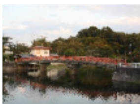
弁天橋 L=40.0m(PC橋) 1979年架設
