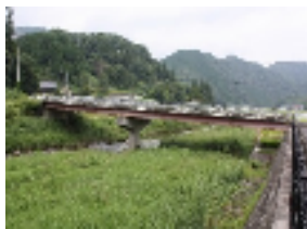
胡橋 L=47.0m(鋼橋) 1983年架設
