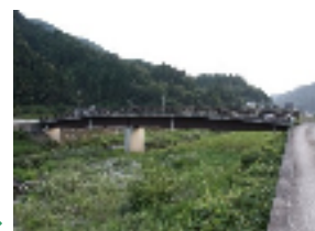
夢乃橋 L=56.0m(鋼橋) 1997年架設
