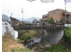
泉橋 L=15.3m(PC橋) 1986年架設
