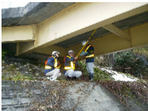
橋梁点検（上部工）
