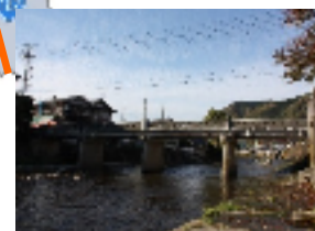
大橋 L=42.5m(RC橋) 1966年架設
