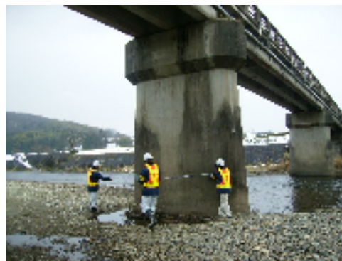
橋梁点検（下部工）
