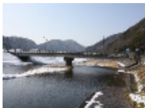
川平橋 L=63.7m(PC橋) 1993年架設
