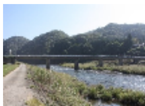
高茂橋 L=100.0m(PC橋) 1966年架設
