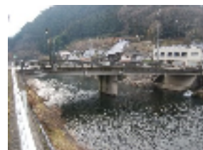
大橋 L=43.8m(PC橋) 1991年架設
