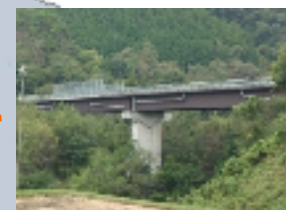
加谷大橋 L=134.2m(鋼橋) 1993年架設 跨線橋
