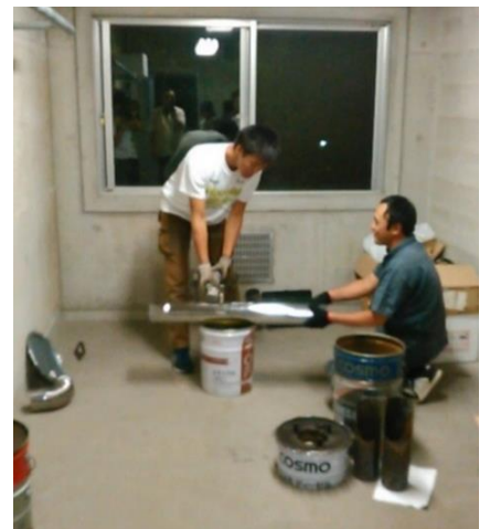
薪をくべて使用する ロケットストーブ作成
