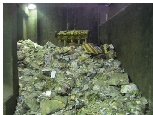
備北クリーンセンターのごみピット
