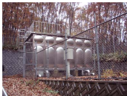
下門田配水池
