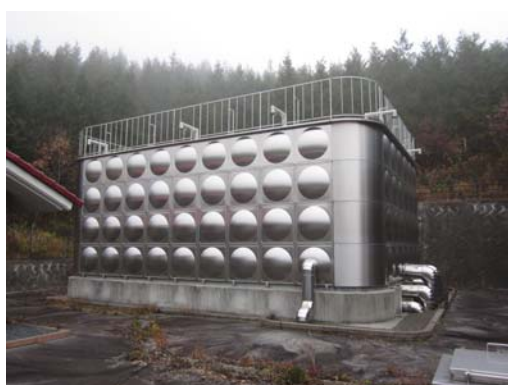
口和簡易水道 永田配水池
