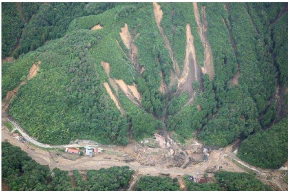
出典：7.16 庄原ゲリラ豪雨をふりかえって、平成 23 年 7 月、庄原市役所 被災状況（篠堂地区）
