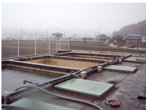
新市浄水場（緩速ろ過池）
