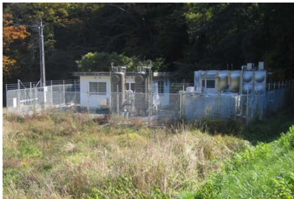
東城帝釈浄水場全景
