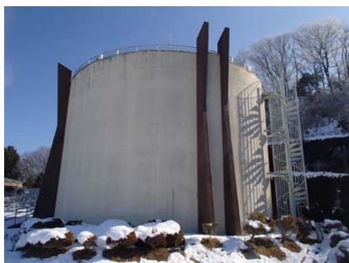
庄原地区上水道 布掛山第 3 配水池
