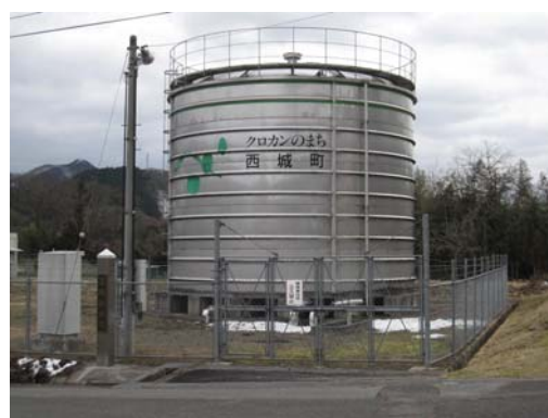
西城第 1 配水池
