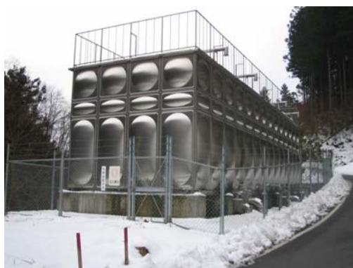
東城地区上水道 矢居谷配水池
