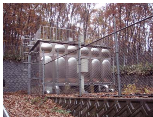
下門田配水池
