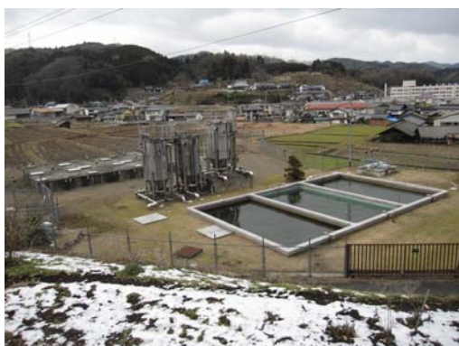
西城浄水場全景
