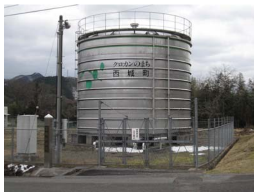
西城第1配水池
