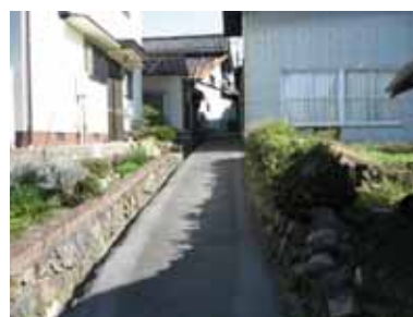
新道地区の狭隘道路
