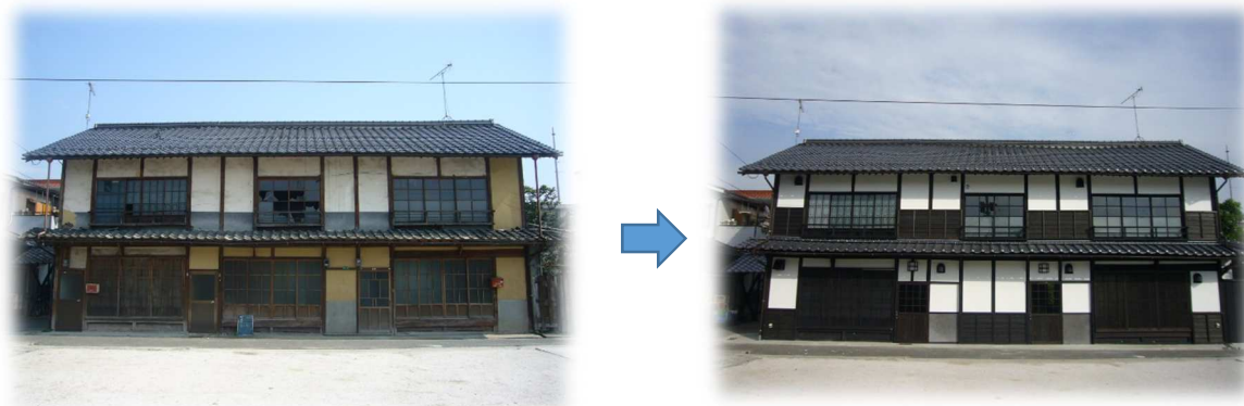
空き家(長屋住宅)を改修し、交流・展示施設として活用した例
