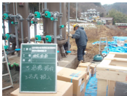
東城統合整備事業のろ過装置設置工事
