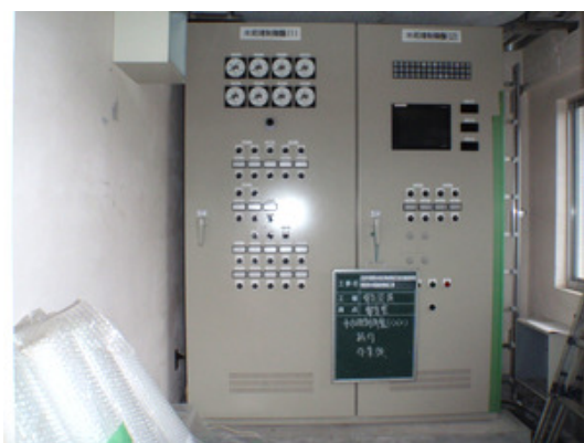
東城統合整備事業の電気設備設置工事
