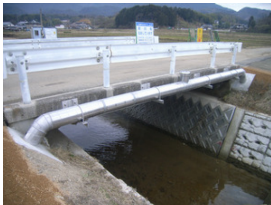
小用・三協地区配水管布設工事（橋りょう添架）
