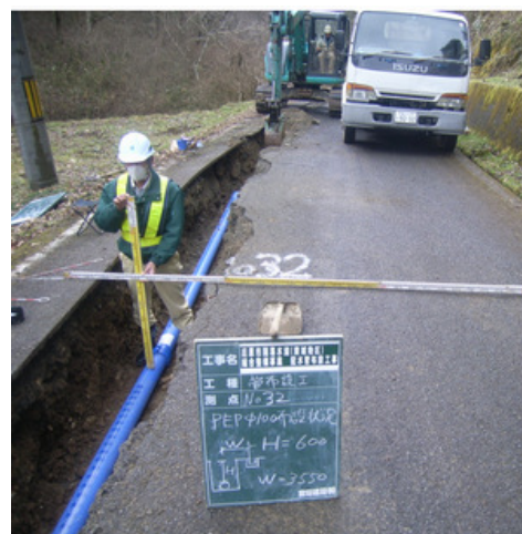
東城統合整備事業の配水管布設工事
