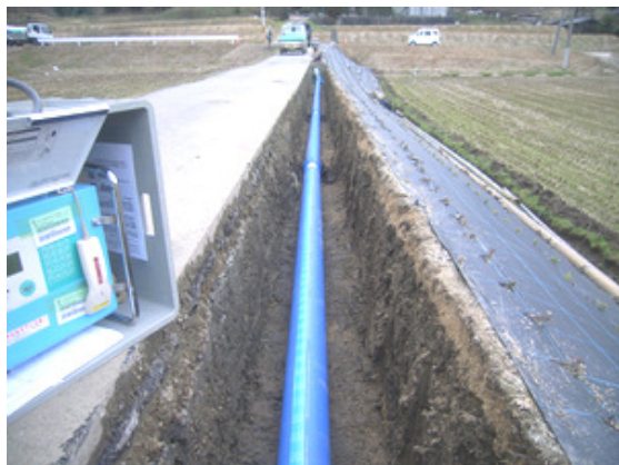
小用・三協地区配水管布設工事
