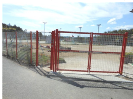
みどり園保育者フェンス改修
