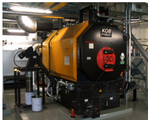
庁舎ペレットボイラー
