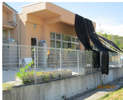
敷信みのり保育所乳児室増築（概観）
