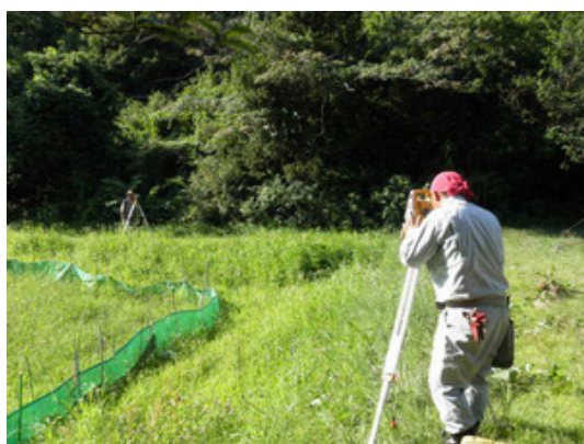
現地で関係者が立会いの後、測量を行います
