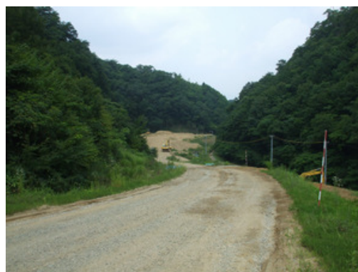
改良中の高茂金田農道
