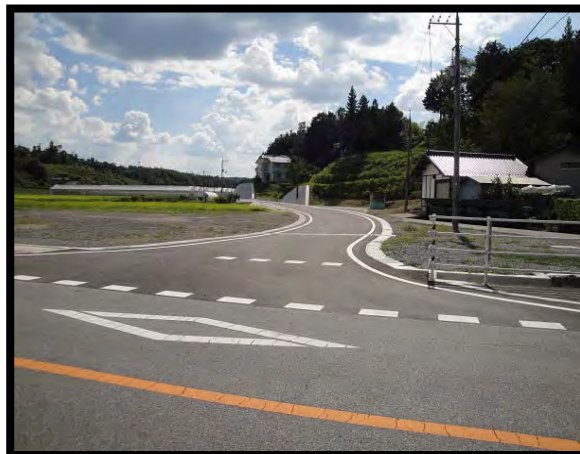
【改良後の市道板橋高門線】
