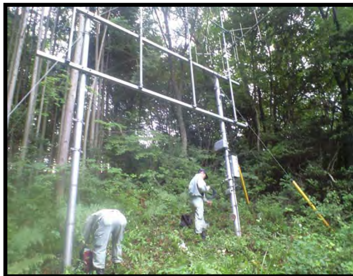
【地上デジタル放送共聴施設の改修工事風景】
