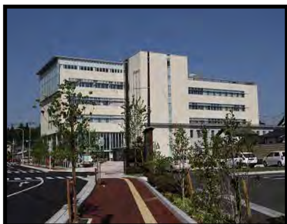
【新庁舎の全景】
