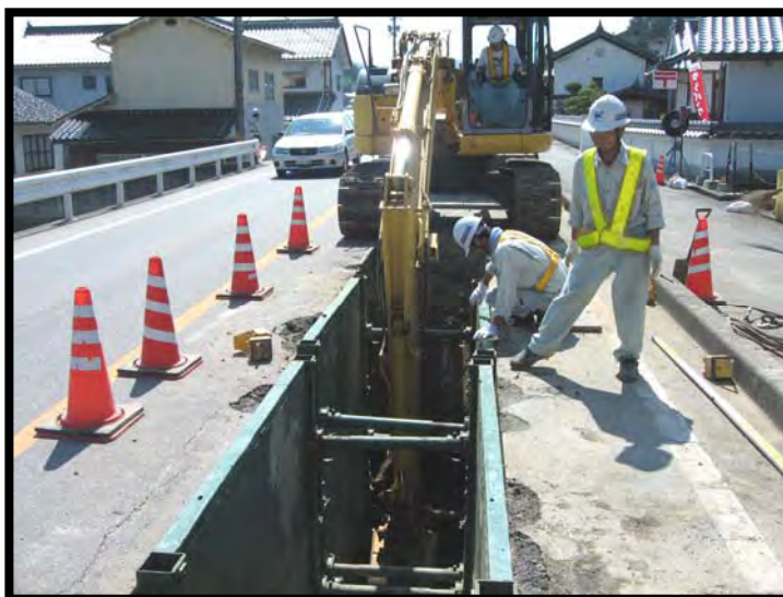
【公共下水道管の埋設工事風景】
