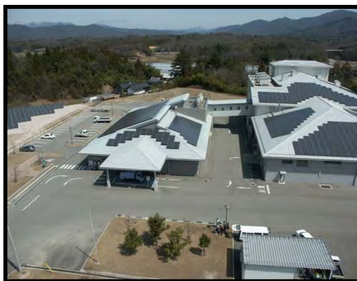
【リサイクルプラザ太陽光発電システム設置全景】
