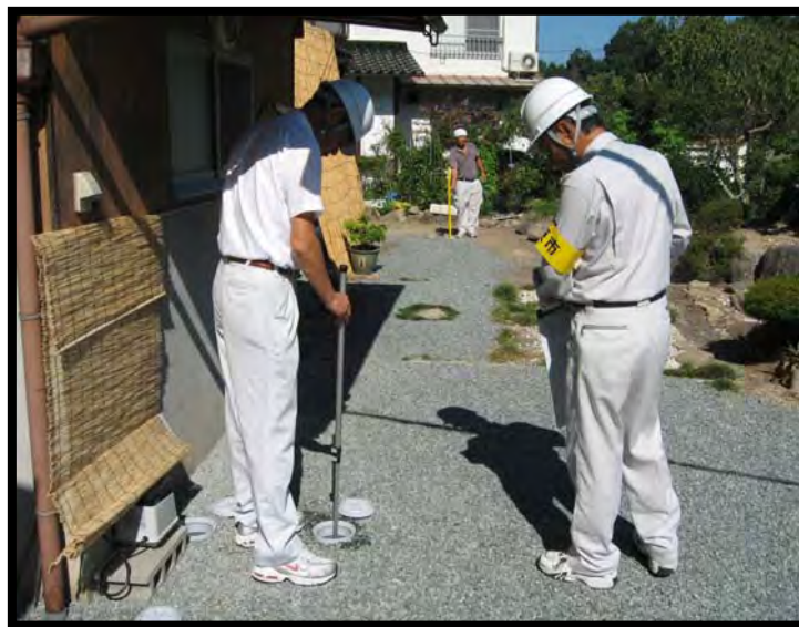
【下水道を接続した家屋への工事検査の様子】
