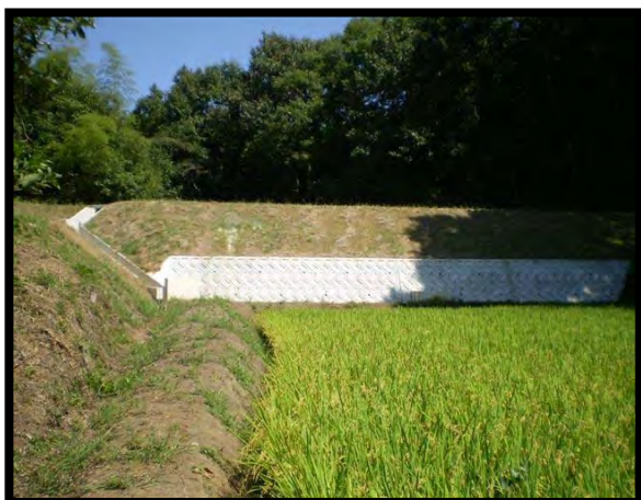
【堤体を改修したため池 (庄原地区)】
