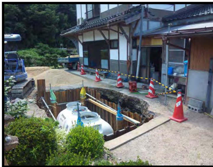
【合併浄化槽の設置工事】
