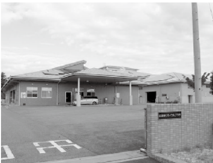
太陽光発電設備が設置されているリサイクルプラザ(是松町)
