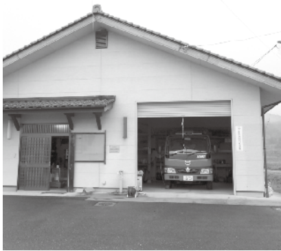
消防格納庫(口和町)
