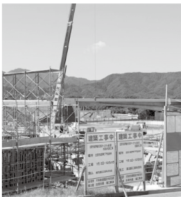
工事中の高野観光交流ターミナル(高野町)
