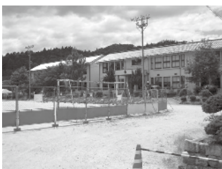
校舎耐震改修工事中の 美古登小学校(西城町)
