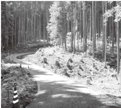
一般県道中領家庄原線道路改良工事(単独)のようす
