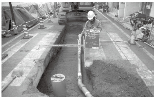
水道管布設工事の様子(東城町)
