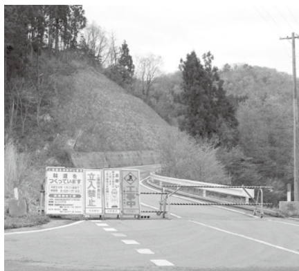
旧緑資源幹線林道支線高尾小坂線 西城・東城区間の様子(東城町)
