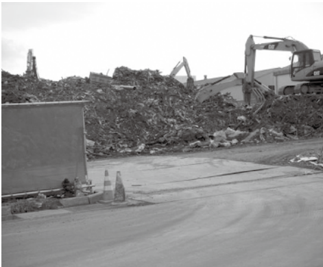
被災地のがれきの様子(平成24年4月撮影) (宮城県気仙沼市)
