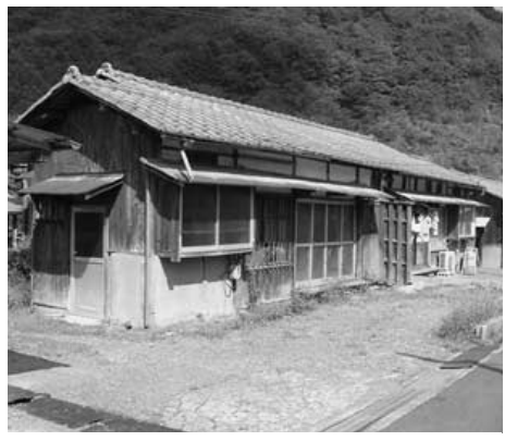
川西公営住宅（東城地域）
