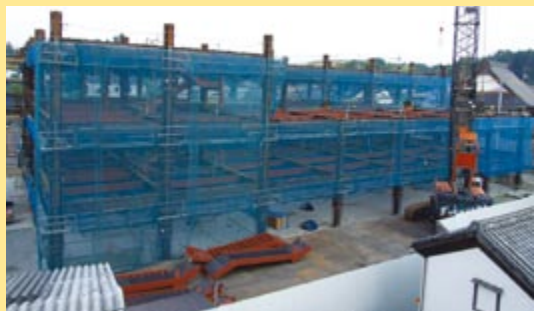
新庁舎建設の様子(8月6日現在)
